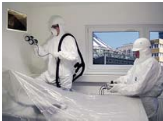
Mit Hilfe eines speziellen Kamerasystems werden Ab- und Zuluftkanäle filmtechnisch erfasst.
